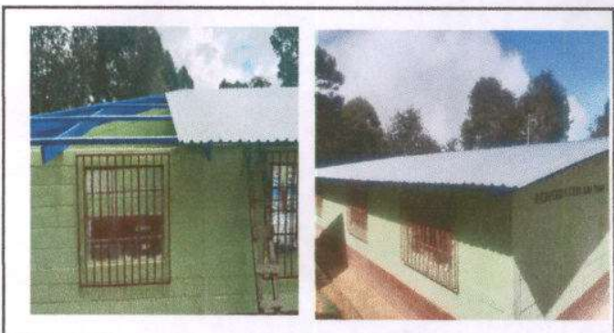
Foto 4 y 5: Parte de atrás del edificio en proceso de colocación de lámina nueva, módulo 1
