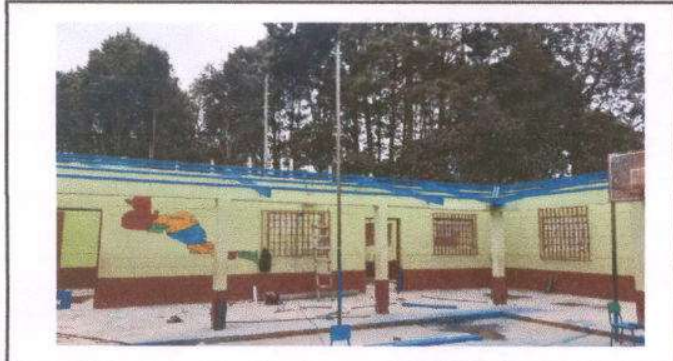
Foto1: Se observa ya colocado el soporte nuevo para la cubierta, módulo 1.
