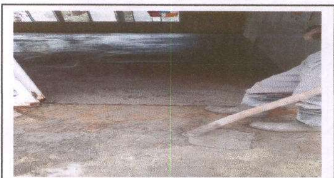
Foto 6: En esta fase se observa la fundición del piso en el aula, modulo 2
