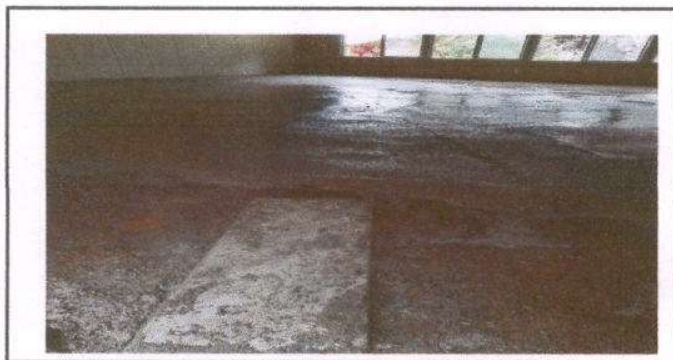
Foto 6. Proceso de colocación del piso en el aula, modulo 2
